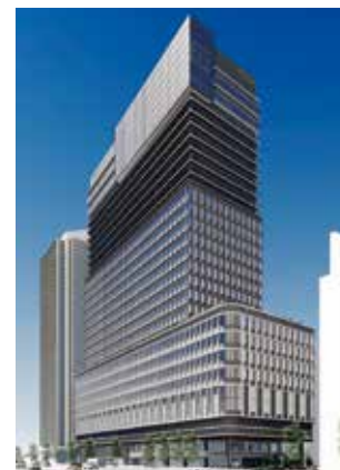
本庁舎2号館再整備事業 2029年度完成予定
