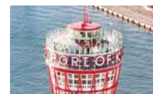
神戸ポートタワー | 2024年4月 リニューアルオープン
