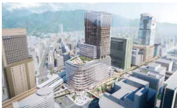
(仮称)JR三ノ宮新駅ビル | 2029年度開業予定
